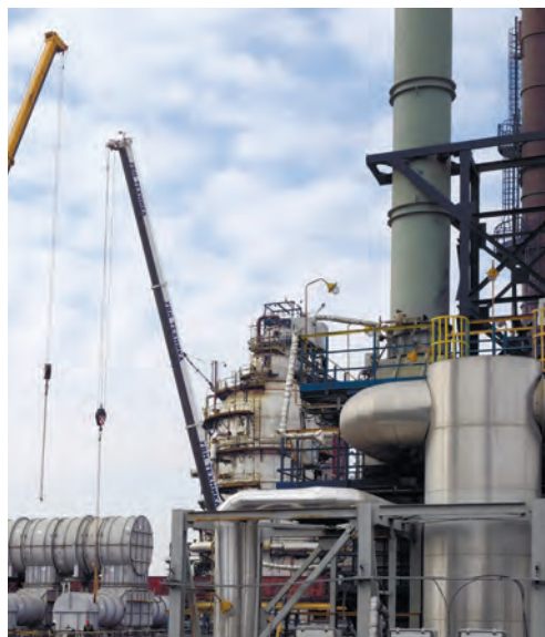
Московский нефтеперерабатывающий завод Реконструкция установки ЭЛОУ-АВТ-6
